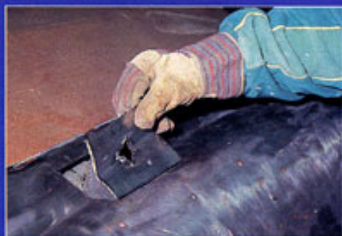
...schadhaftes Blech großzügig heraustrennen und dann mit dem Schutzgasgerät einschweißen
