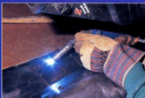
Wichtig beim Schweißen ist, daß ständig die Seiten gewechselt werden, um Verwerfungen zu vermeiden
